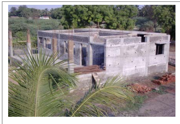
Unsere Apotheke und Erste-Hilfe-Station in Pondicherry während der Bauphase
