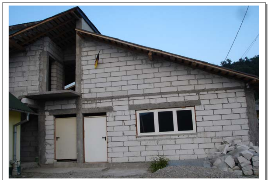
Der fertige Rohbau unserer Berufsförderungswerkstatt in Valea Corbului
